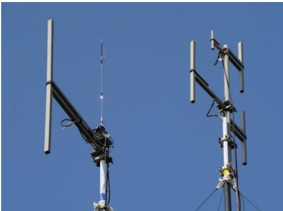
Båda antennmasterna grupperade sida vid sida med dipoler för 80, 125, 160 och 380 MHz
