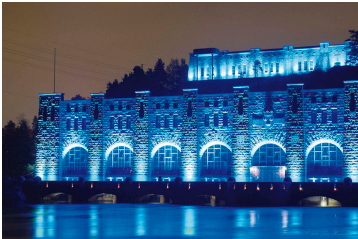
Kraftstationens pampiga granitfasad under ljusshowen.
