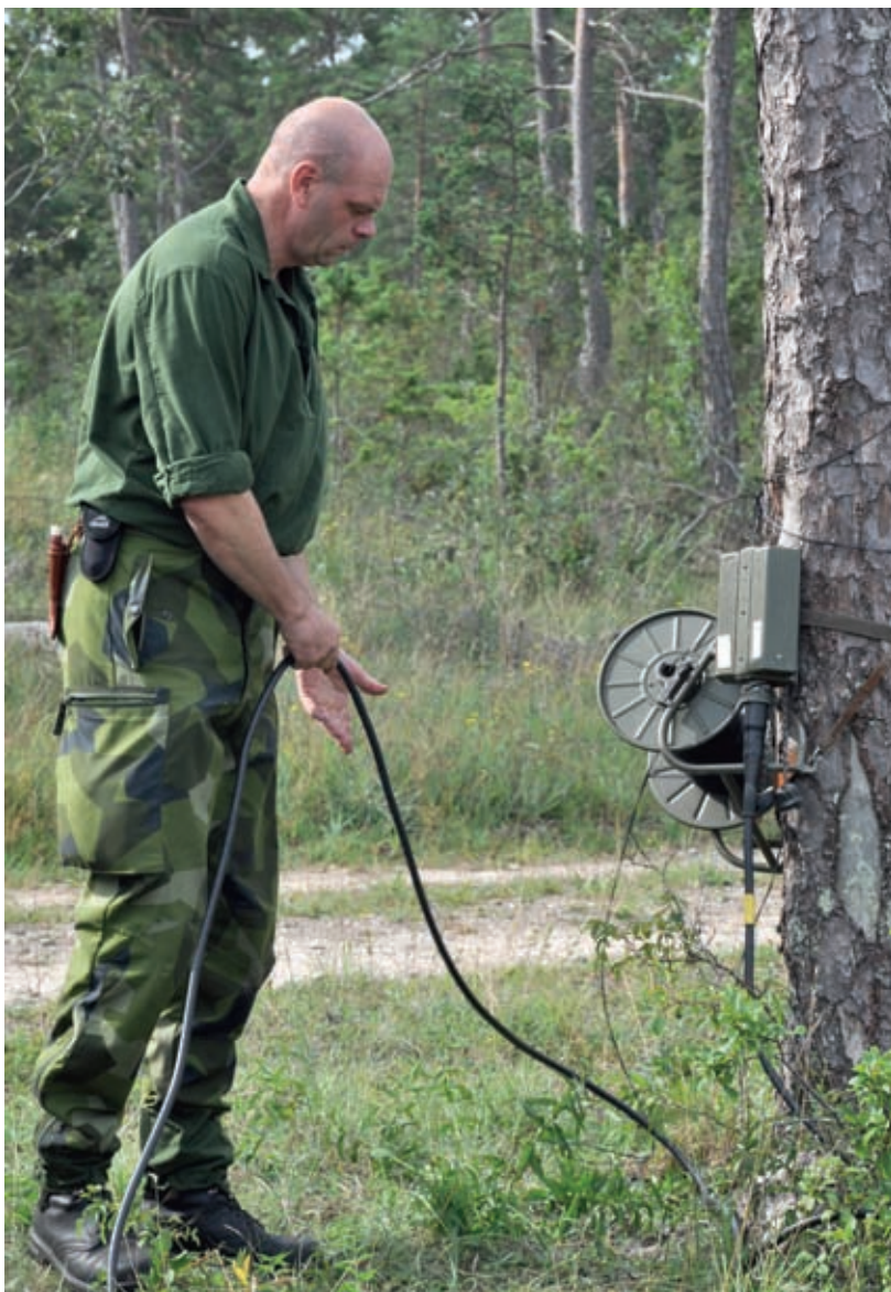
Arne Nordh från stabs- och sambandstjänstkursen kontrollerar stationskabeln från plinten till telefonväxeln i stabstältet.
